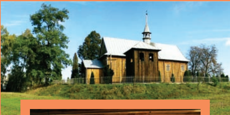
Kościół pw. Przenajświętszej Trójcy
