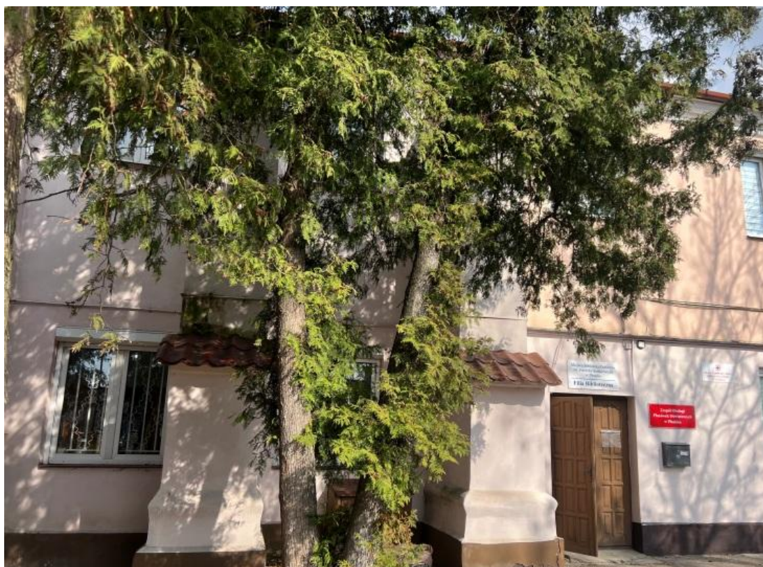
Budynek Filii Bibliotecznej przy ul. Płockiej 19 wygląda tak.
